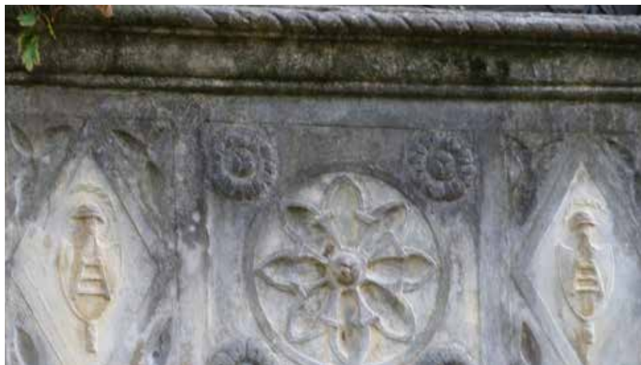
Particolare della finestra con emblemi scaligeri.
