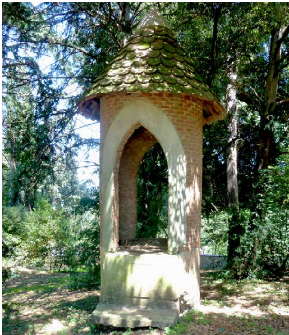
Il cinquecentesco pozzo dei frati al limitare del bosco verso l'ingresso che dà sulla Dorsale dei Berici, forse modifica di un pozzo preesistente.
