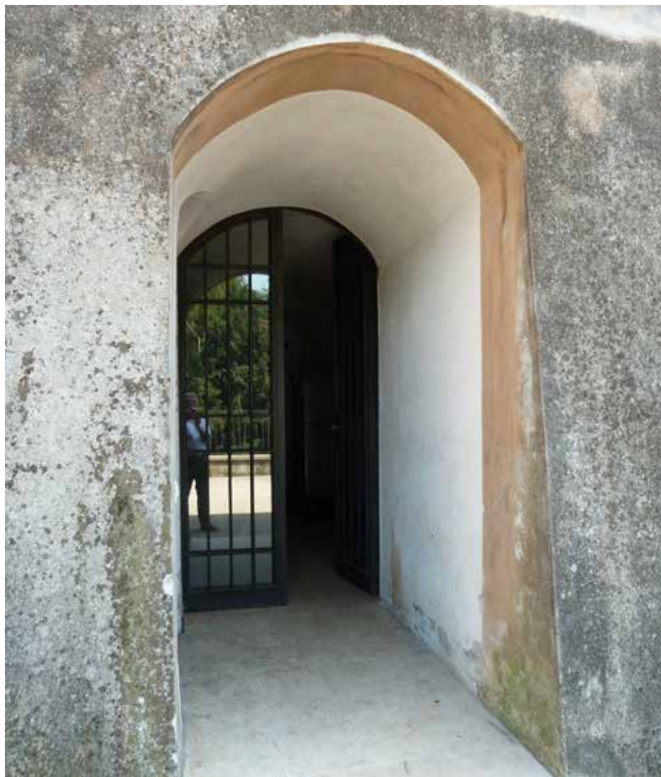
Accesso alle cantine del Castello: la parete delle mura di base dell'antica fortezza romana ha 2 metri di spessore.
